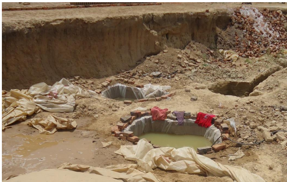
Figura 24. Almacenamiento de agua para la elaboración de la mezcla.
