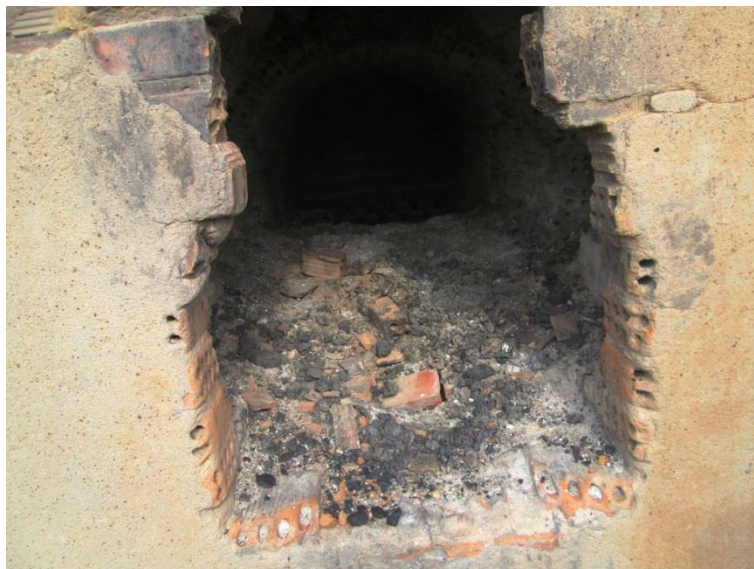
Figura 26. Entrada de combustible en el horno
