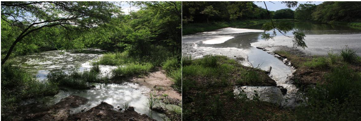
Figura 8. Lagunas de oxidación de municipio de La Paz, en estado de abandono.
