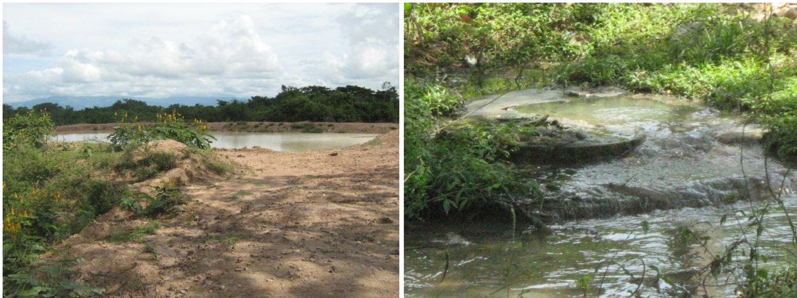
Figura 9. Instalaciones del sistema de tratamiento y sitio del vertimiento de aguas residuales en Antequera.
