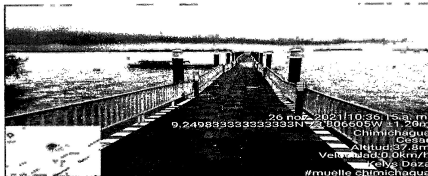
Imagen No. 1: Diligencia de Inspección. Fuente: Propia.
