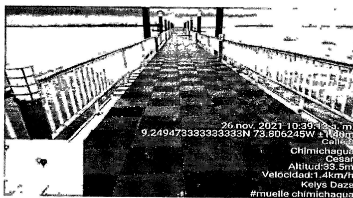
Imagen No. 6: Barandas desajustadas y luminarias que no funciona. Fuente Propia.
