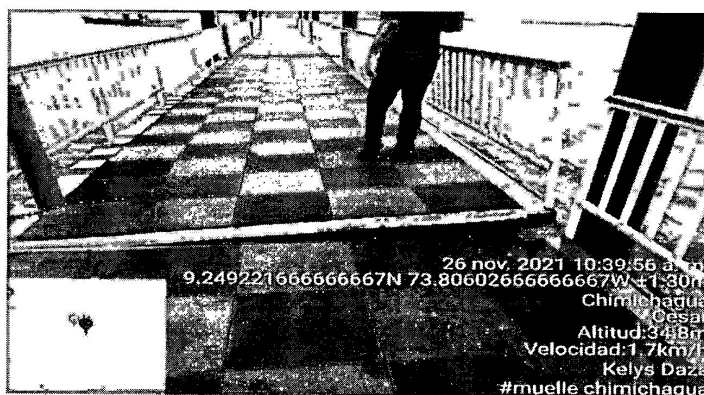
Imagen No. 5 Condiciones actuales de desprendimientos de las barcasas. Fuente Propia.
