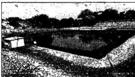
Foto 5. Piscina de almacenamiento de lixiviado de celda de biorremediación
