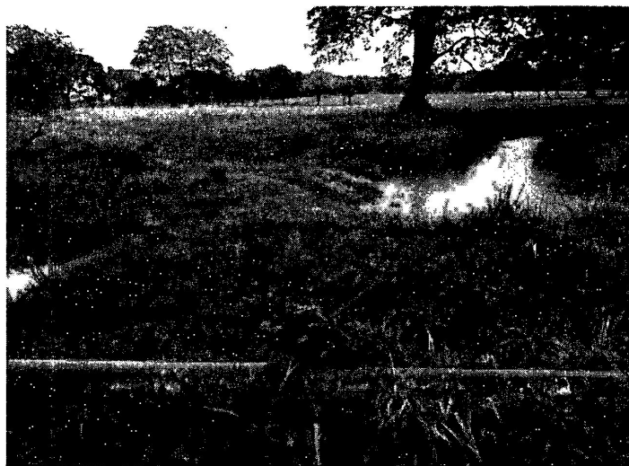
Imagen No. 4: Condiciones en las que se encuentra la tubería expuesta". Fuente Propia.
