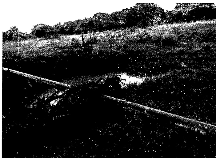
Imagen No. 3: Condiciones en las que se encuentra la tubería expuesta en el Caño Calarcá". Fuente Propia.
