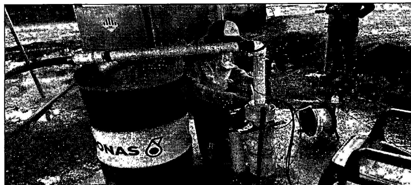
Imagen 2. Punto de captación (pozo profundo). Fuente: Propia
