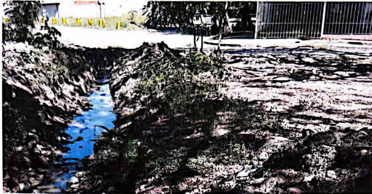
Foto 2 – Manjol rebosado, ubicado frente la vivienda 1
