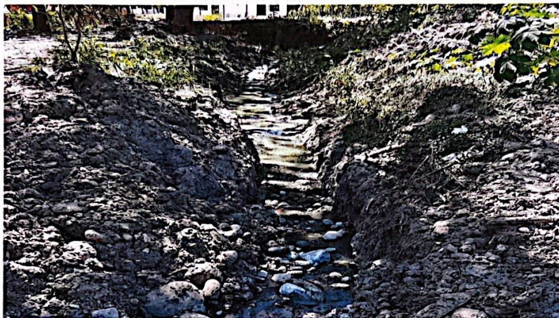
Foto 5 – Canal de conducción de las aguas residuales
