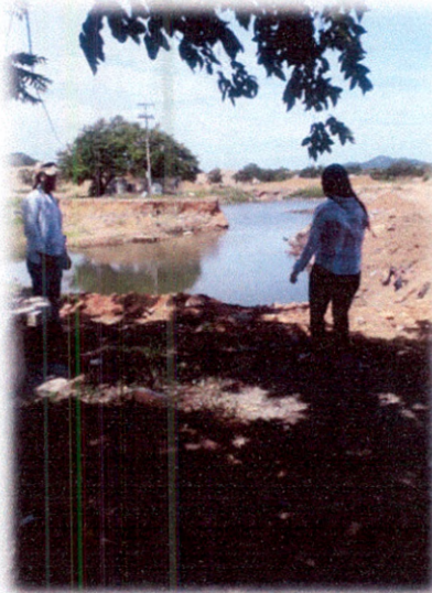
Imagen 2, Zona de Captación
