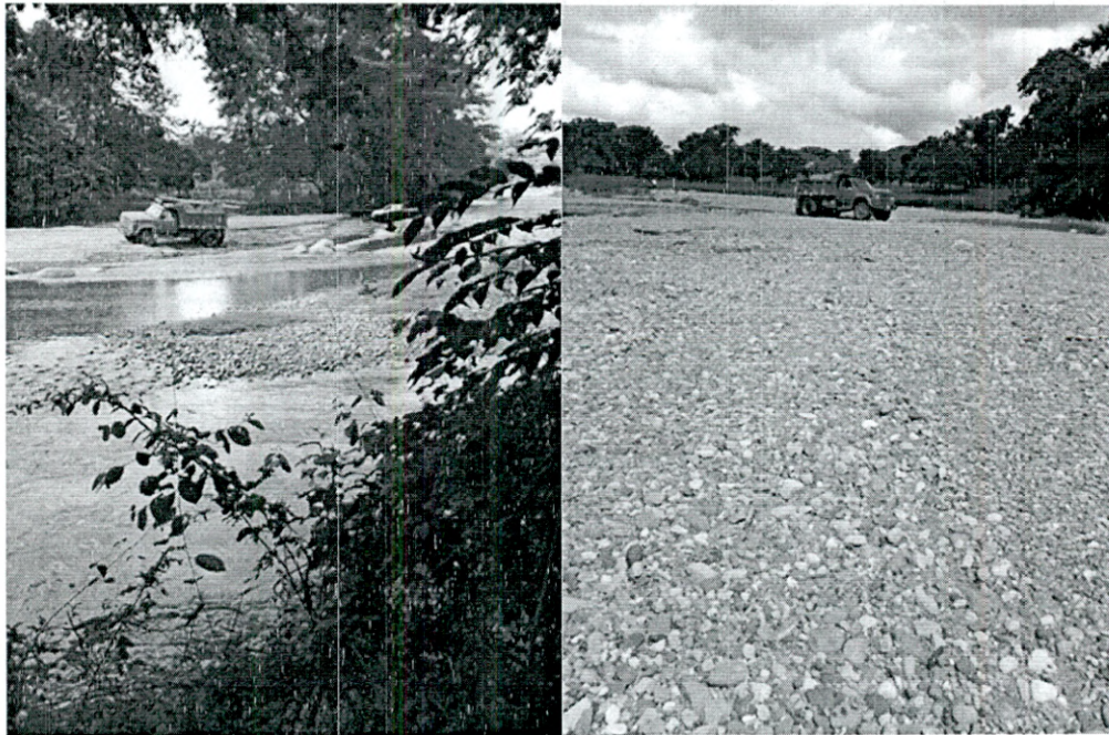
Fotografía 5. Volquetas doble troque realizando labores de cargue y transporte artesanal de material sobre el lecho del río.
