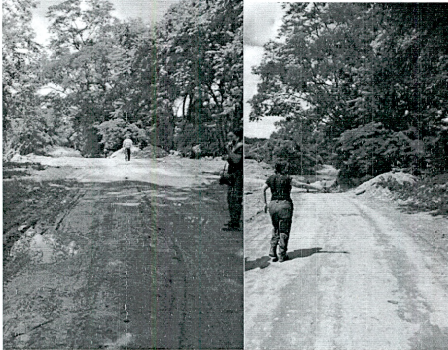
Fotografía 4. Vías sin geometría definida y en mal estado, sobre la ronda hídrica del río.
