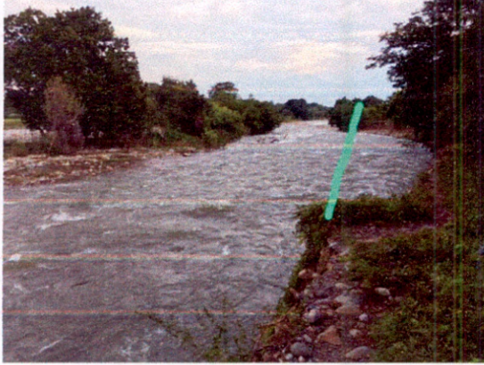
Imagen N°5 Desvío del cauce del río
