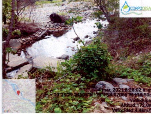
Imagen N°6 Restos de bocatoma
