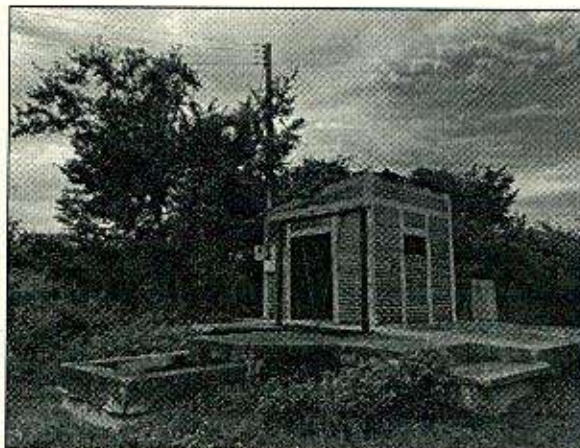
Estación de bombeo
