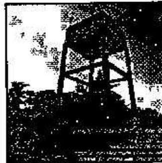
3. Tanque de almacenamiento
