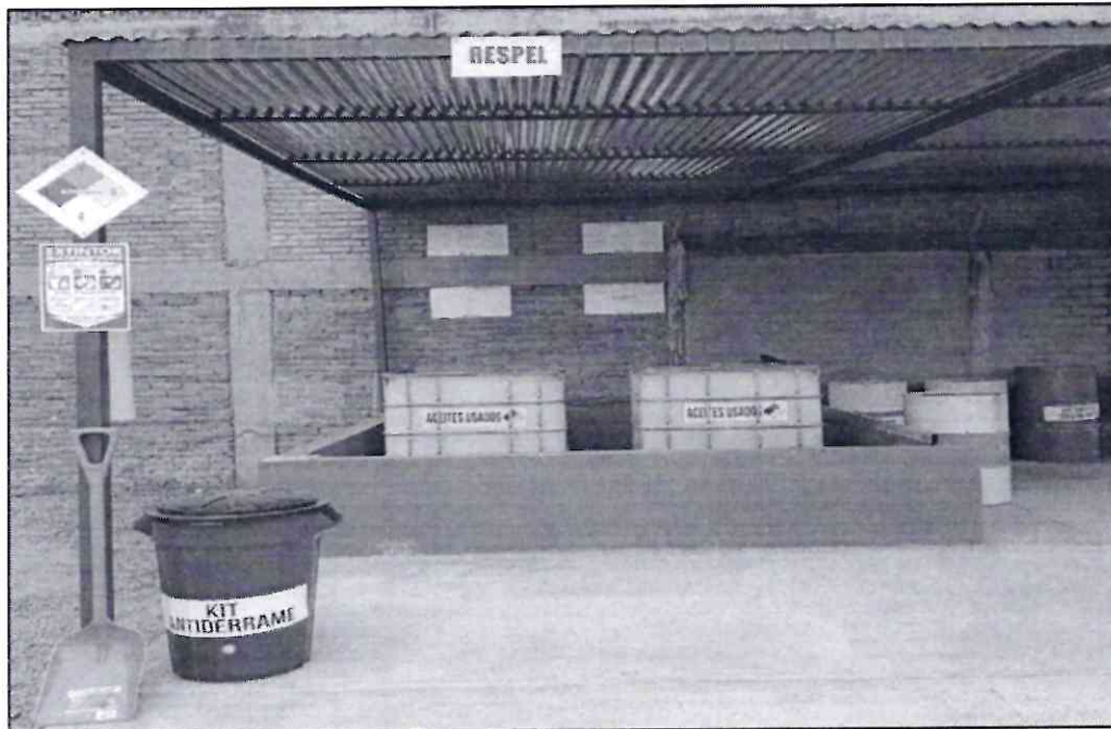
Figura 1. Zona de almacenamiento de Residuos Peligrosos
