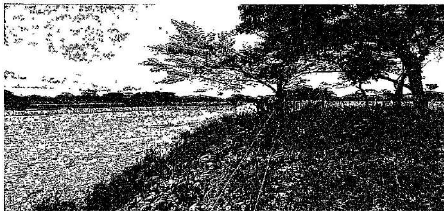
Ilustración 4. Sitio de ocupado por obras de geotecnia y bajado de tubería PK 04+690 del Combustoleoducto Galán - Ayacucho - Coveñas - Cartagena de 16".
