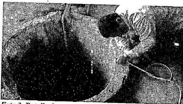
Foto 3, Detalle de características del aljibe Pororó
