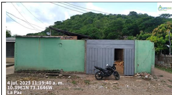
Fotografía 2. Infraestructura de las instalaciones.
