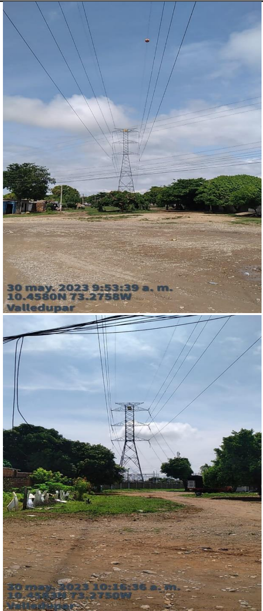
Torre 204 Barrio Galán entrada a la subestación de Valledupar.
