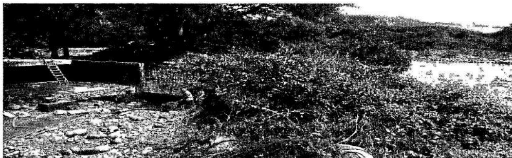
Ilustración 5. Avance del box culvert doble, antes de llegar al Sitio de Ocupación propuesto en el margen derecho del Río Guatapurí.
