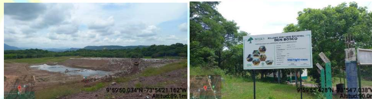
Seguimiento a LA relleno sanitario
