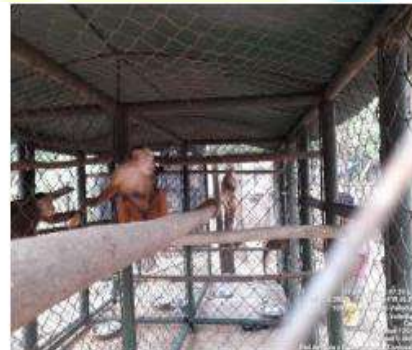
Adecuación e instalación de perchas
