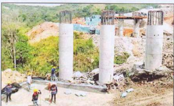
AVANZA LA construcción del puente en la vía Panamericana, en Rosas, Cauca. /Mintransporte
