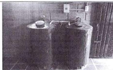
Foto 4. Filtros prefabricados
