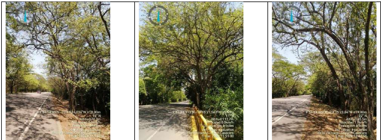
Arriba, los registros fotográficos muestran a los diferentes árboles invadiendo la parte aérea del área de rodamiento, los cuales están propensos a colapsar, sea parte del árbol o todo debido a la corteza incluida en sus bifurcaciones.
