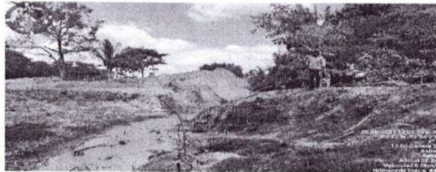
Foto 1. Drenaje Perete, sitio del puente Cascajo k2+070.
