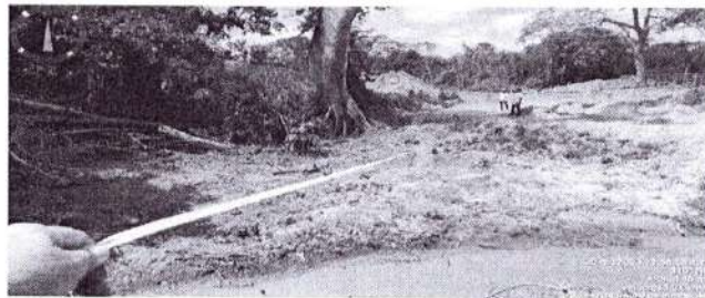
Foto 2. Drenaje Perete, sitio del puente Cascajo k2+070.
