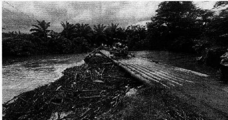
Imagen 9. Acumulación de material vegetal amenazando la estabilidad de una estructura de paso existente en Quebrada La Floresta en cercanías de Las Brisas – Fuente: propia
