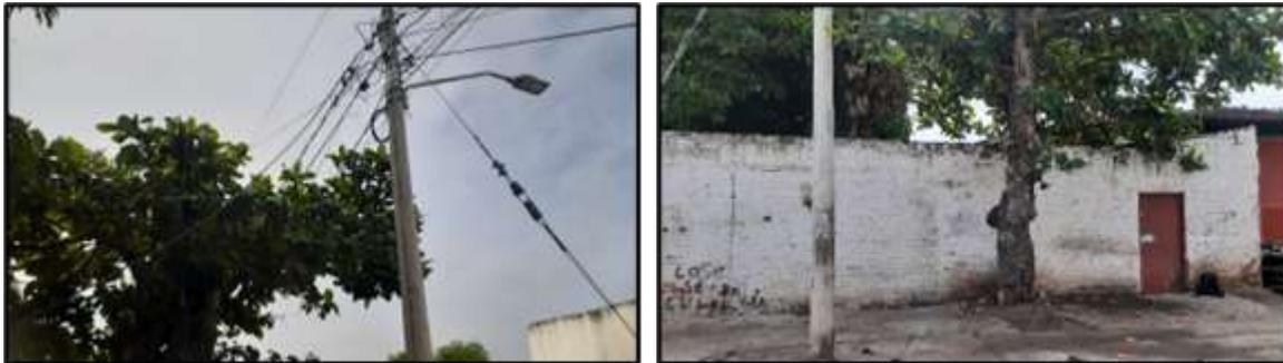
**Figura 5.** Contacto de las ramas con redes eléctricas y separación del poste.
