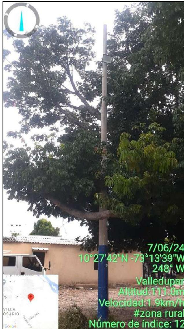
*Fig. 8 Detalle del desarrollo de copa interfiriendo el cono de luminosidad de la lámpara sobre el poste*
