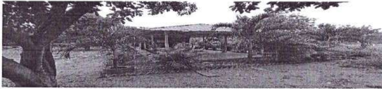
Foto 4. Vista general infraestructura predio Los Corazones
