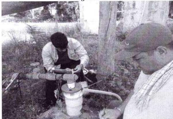
Realización Prueba de Bombeo.2
