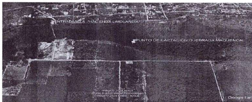
Imagen. Descripción acceso al Punto de Captación.
