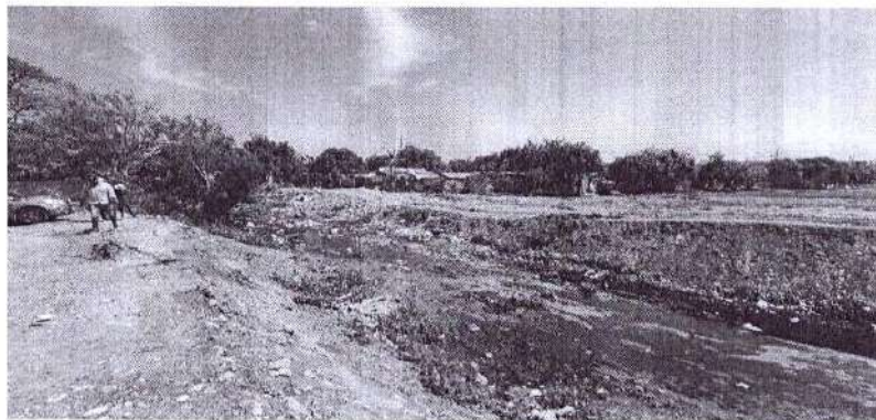
Imagen 8. Cauce en el punto de cruce con la Calle 67 (Coord. Geog. Ref. 73°15'58.92"O 10°25'59.87"N)– Fuente: Propia
