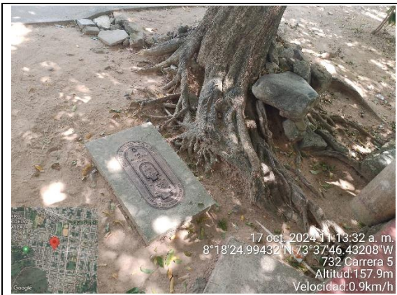
IMAGEN 1- se evidencia, la ubicación del arbol, al lado del registro del agua potable y las raíces expuestas al aire. FOTO. autor
