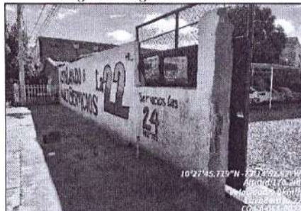
Imagen 2. Ingreso al lavadero
