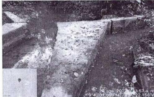
**Imagen 4, Obra tipo partidor automático ubicada en el predio Opilandia. Fuente: Propia**
