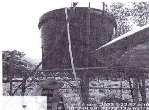
Imagen 4. Localización tanque de almacenamiento de agua
