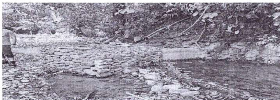
Foto 1 y 2. Captación lateral Quebrada Noream
