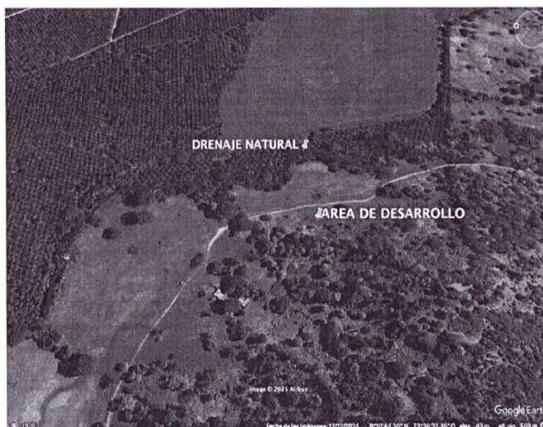
Imagen. Vista general trazado del drenaje natural que rodea al proyecto
