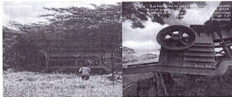
Imágenes. Vista general sistema de tolva de alimentación y trituradora primaria de mandíbula.
