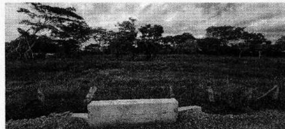
**Imagen 7. Drenaje menor de escorrentía (Coord. Geog. Ref. 73°36'22.6"O 9°14'39.5"N)<sup>10</sup> Obra ejecutada existente en el momento de la visita – Fuente: propia**
