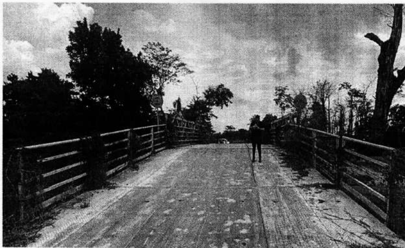
Imagen 1. Sitio propuesto para ocupación tramo Morrison - Pita Limón PK 9+090
