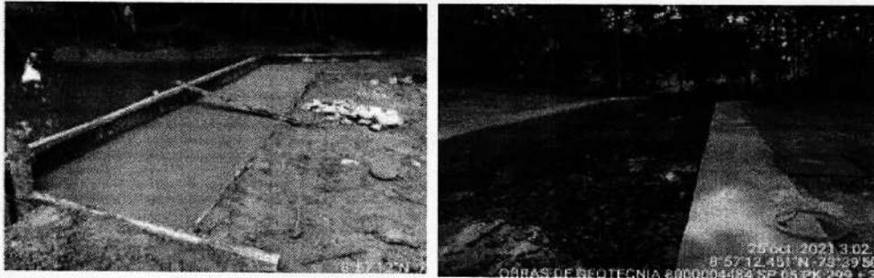
Ilustración 12. Recubrimiento de gaviones con concreto de 3000psi
