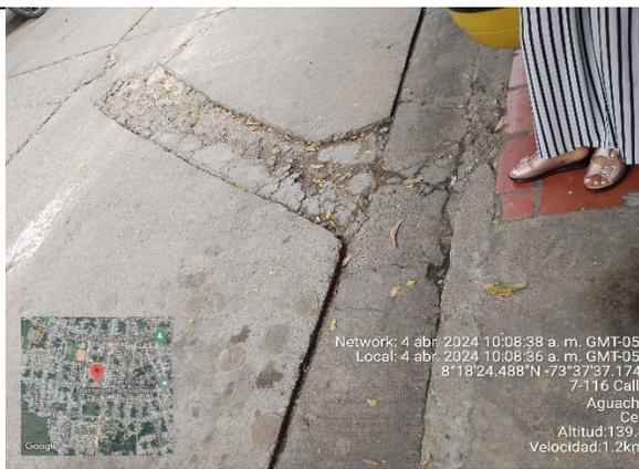
*IMAGEN. Rotura del piso por presuntas daños de alcantarillado por las raíces del arbol de Guaiacum officinale
