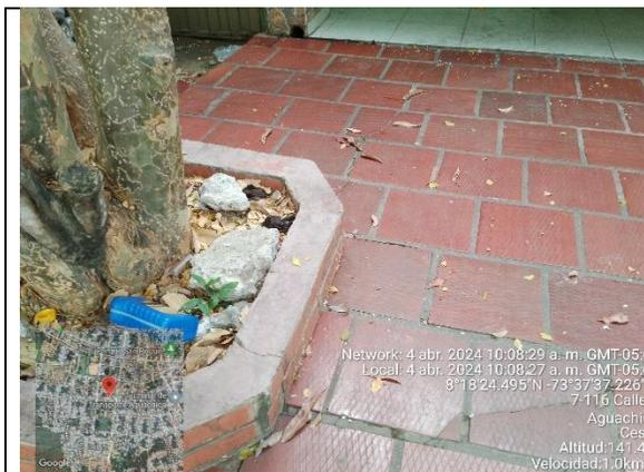
*IMAGEN. Evidencia de fracturación del piso de la casa
