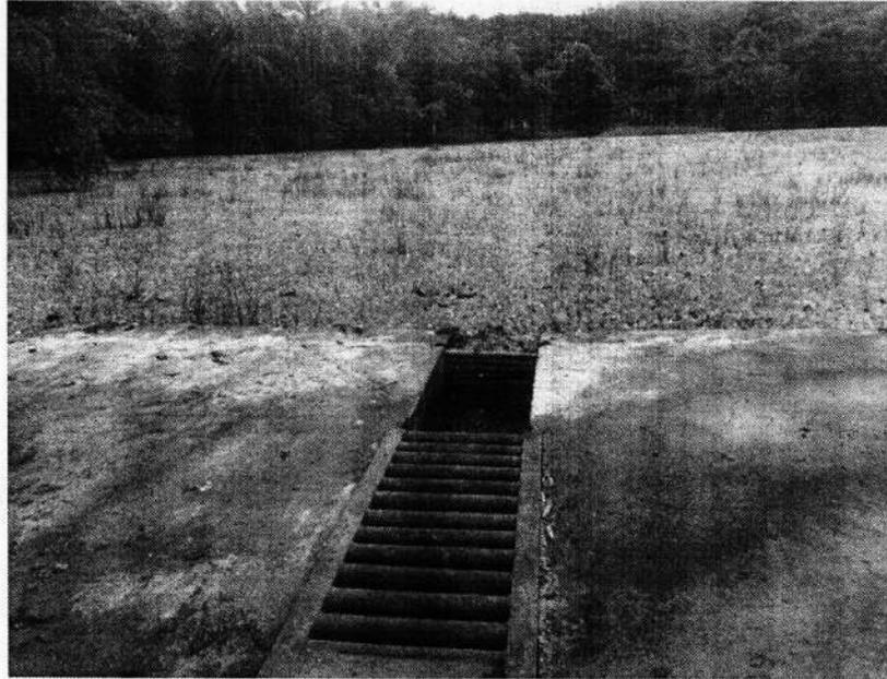
**Imagen 5, Reservorio de almacenamiento y vertedero de exceso.
