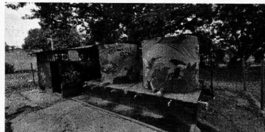
Fotografía 3. Infraestructura de PTAP existente
