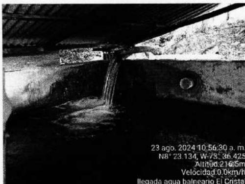
**Foto 6. Detalle tubería de alimentación tanque distribución**
