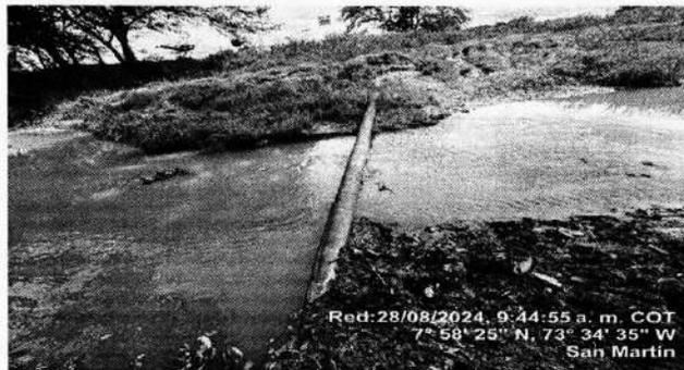
Ilustración 1. Situación de tuberías expuestas Oleoducto Ayacucho Galán 8" en cruce subfluvial con Caño Playoncito.
