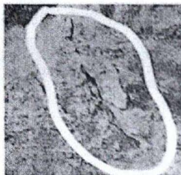
Foto 27A. Detalle del talud de la Foto 23, mostrando localización de grieta por falta de soporte del material
