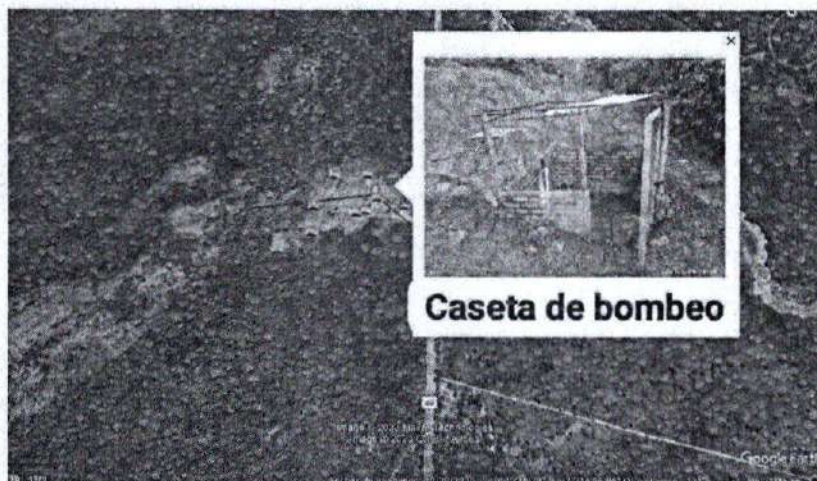
Imagen. Vista general, zona de caseta de bombeo, si operación Fuente. Corpocesar 2023
