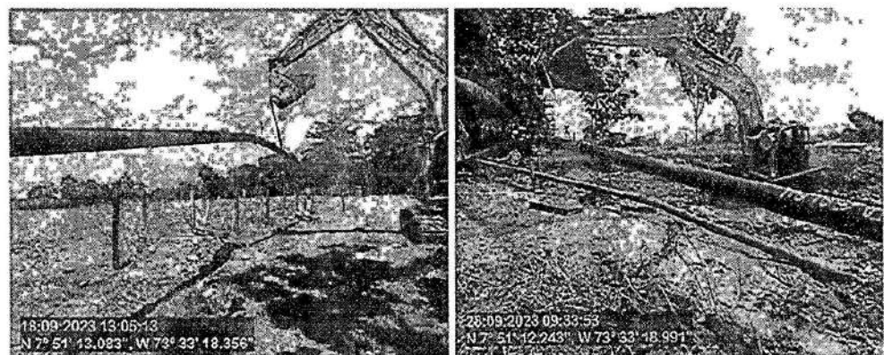
Imagen 11 e Imagen 12. Actividad de posicionamiento de lingada en el DDV - PK 85+358 Galán Ayacucho 8"
