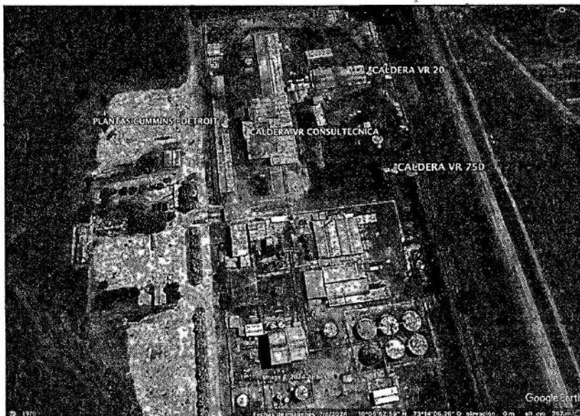
Imagen 3. Ubicación de los equipos que generan emisión y los sistemas de control de emisiones Fuente: Google Earth pro
