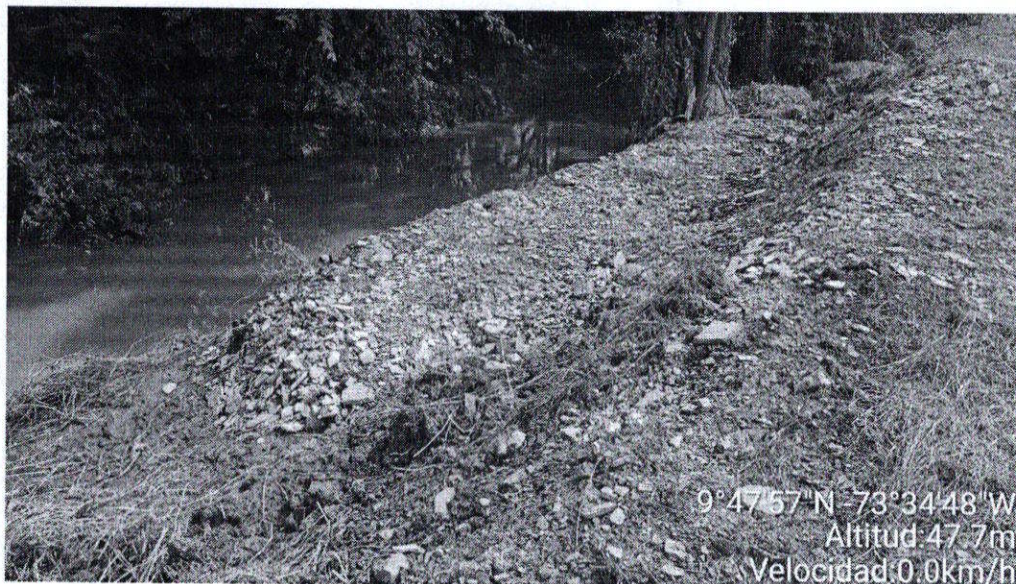
Imagen 7. Visualización de Residuos RCD en terraplén
