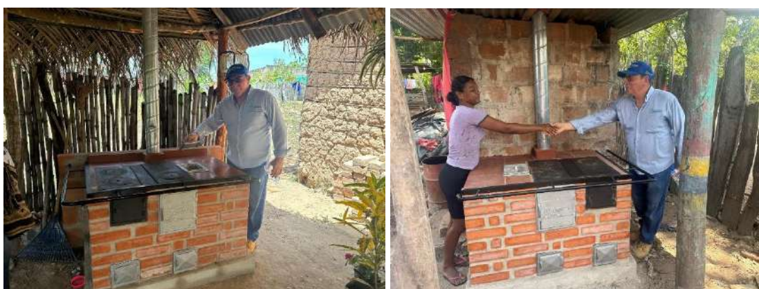
Imagen 19: Construcción de estufas del proyecto
